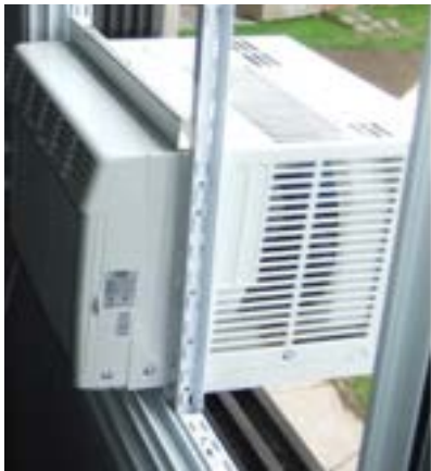
Trous prépercés sur les côtés du climatiseur
